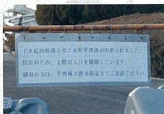
和歌山市の中央終末処理場。職員の削減で部署は相次ぎ閉鎖されている。1979年建設に着手したものの、計画処理能力のうち約35%が使われていない。土地の多くは更地のままだ
