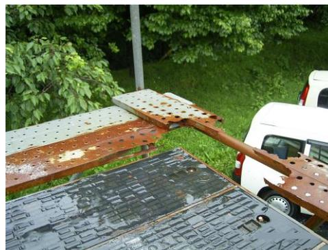
写真 2 点検歩廊の腐食
