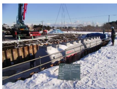
写真3 施設設置状況
