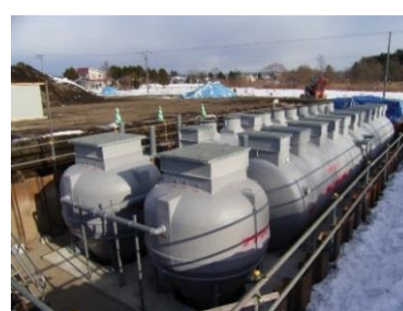
写真4 施工設置完了
