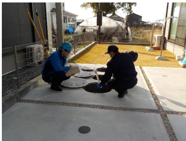
図3 協会職員と保守点検事業者によるチェックの様子
