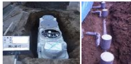
合併浄化槽設置
