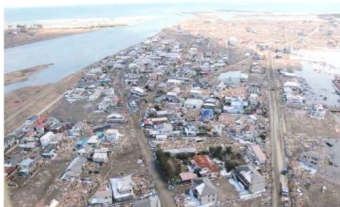
写真2 被災後の状況
