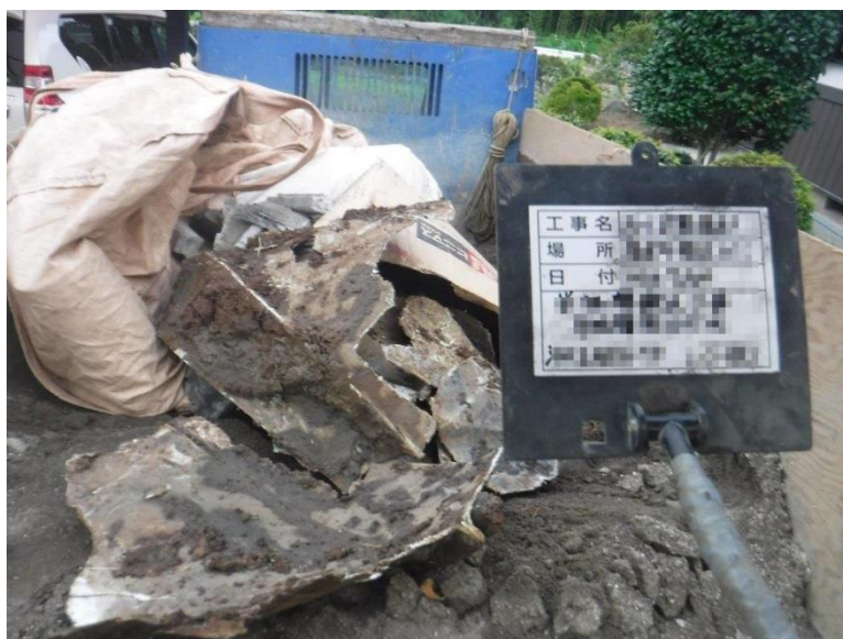
写真 8 廃棄物積み込み
