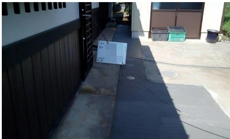
写真 7 スラブ打設 完了
