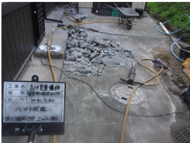
写真2 スラブ撤去 この時は単独処理浄化槽側も同時に実施
