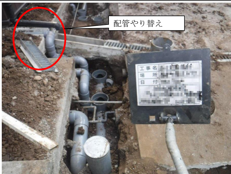
写真3 配管付け替え工事
